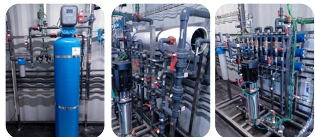
Imagen 3. Tren de pretratamiento de la segunda etapa LIFE Conquer, de izquierda a derecha: resina de intercambio iónico, membrana de nanofiltración y ósmosis inversa.
